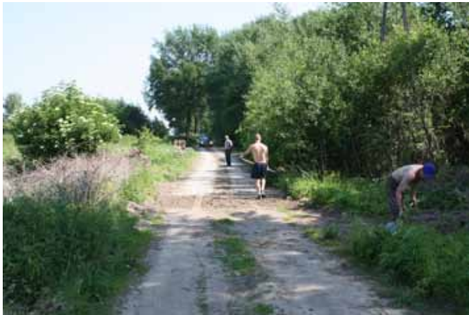
Utwardzenie drogi w Nowych Wyszomierkach
