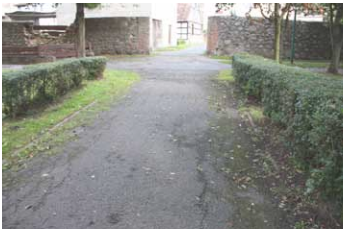
a tak wyglądało przed remontem
