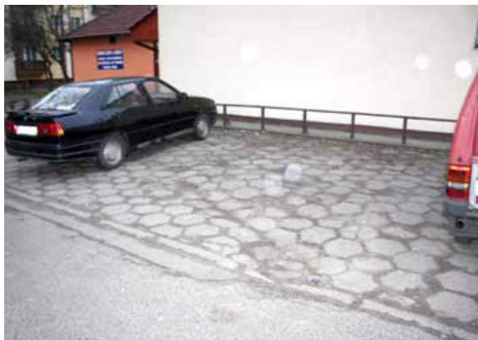
Tak wyglądał parking przed remontem...
