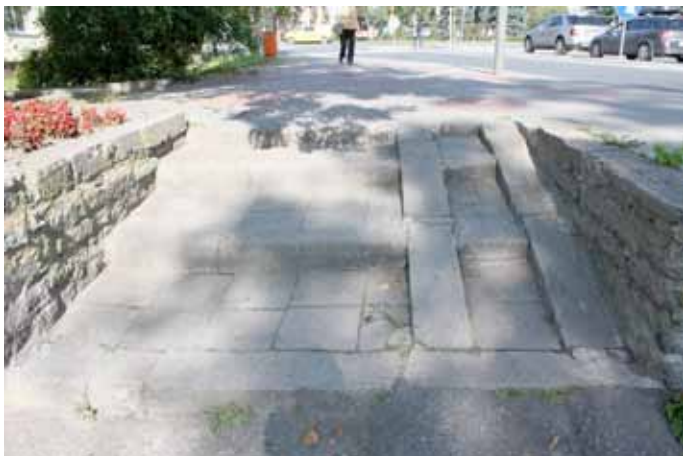
Przed remontem schodów
