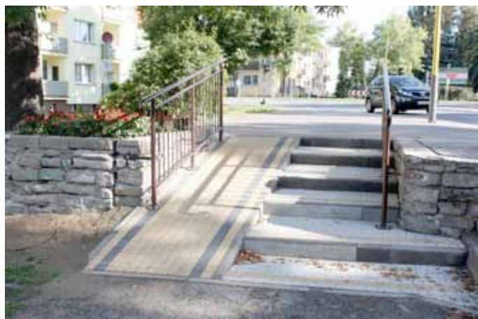
Po remoncie schodów
