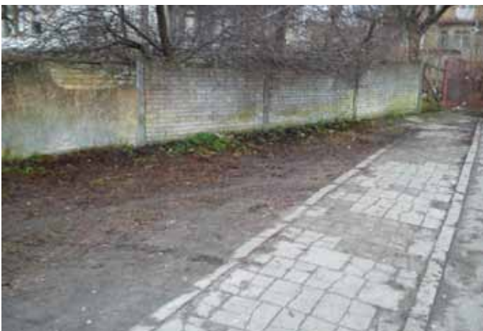
uprzątnięty łącznik Przystań - 3go Maja
