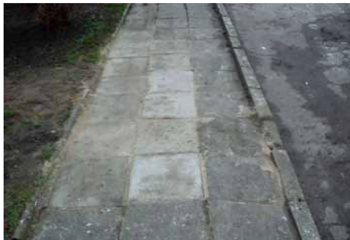
naprawę nawierzchni chodnika przy placu manewrowym przy Przystani
