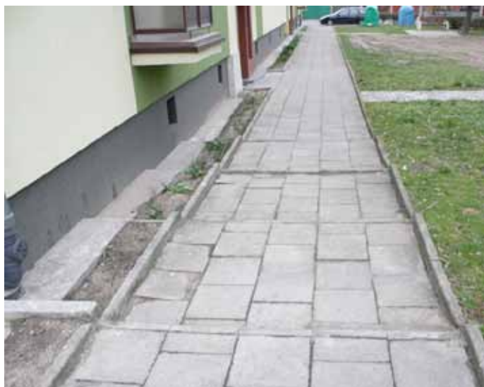
Tak wyglądało przed remontem...
