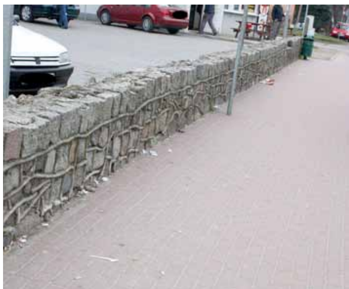
Tak wyglądało przed remontem...
