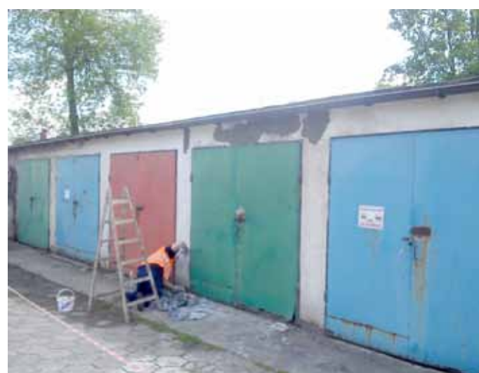
Remont elewacji przedniej ściany garaży przy szpitalu
