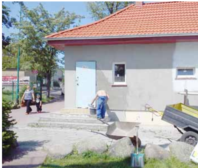
Remont elewacji budynku na plaży miejskiej
