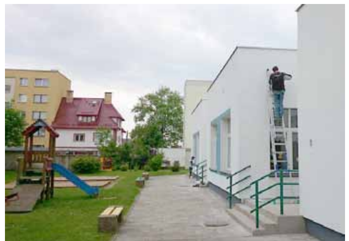
- prace wykończeniowe przy remoncie elewacji Przedszkola nr 3;
