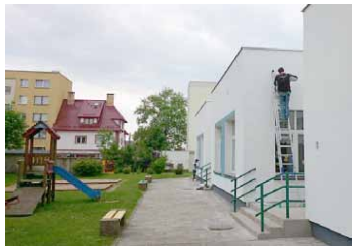
- prace wykończeniowe przy remoncie elewacji Przedszkola nr 3;
